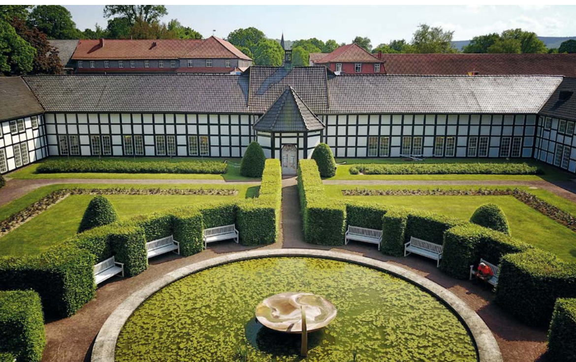
Das Brunnenhaus mit den Heilquellen in der Mitte der Brunnenarkaden bildet ein Oktagon (Achteck) und ist der Ursprung des Gräflichen Parks. Ohne die Heilquellen wäre das ehemalige Kurbad und heutige Hotelresort nie entstanden. Ein Oktagon ist das Symbol für Vollkommenheit und Erneuerung. (Foto: Mateo Hamann)
