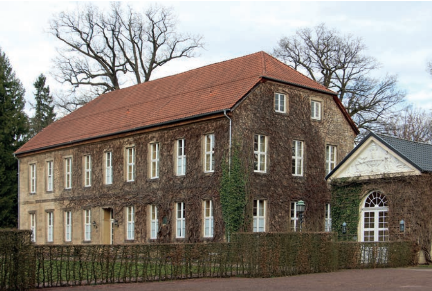
Das Droste Haus wirkt imposant – im Vordergrund ist das Lesezimmer zu sehen (Foto: Anna-Lena Thuns)
