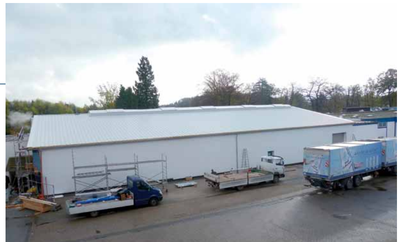
Neues Dach, dichte Halle!
