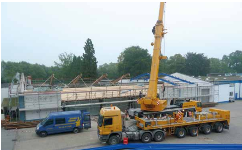
Der gigantische Kran war notwendig, um die Stützen der Halle zu bewegen: die alten raus, die neuen rein. (Fotos: Irina Paß)
