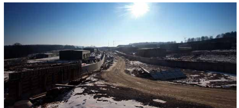
Die Bauarbeiten gehen gut voran.
