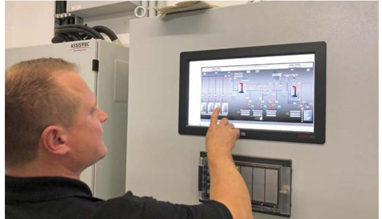
Foto oben: Elektronisch werden auf dem Display alle Heizkreise der Gebäude der Park Klinik abgebildet und können digital gesteuert werden.
