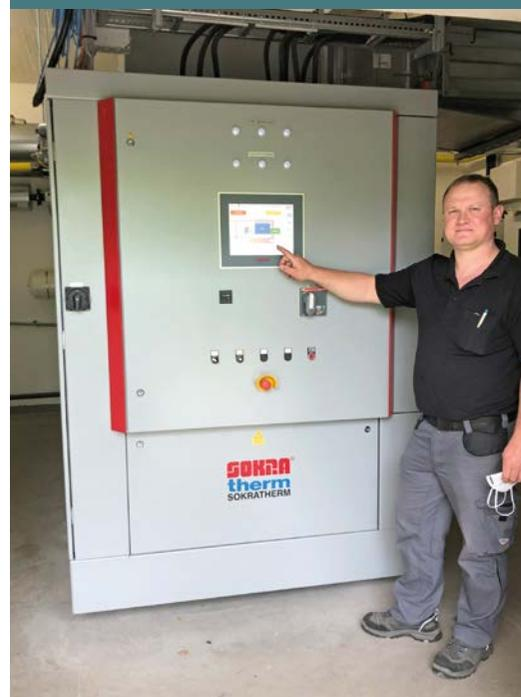
Foto links: Jürgen Brunz, Haustechniker in der Park Klinik erklärt, dass auf dem Display die Leistung aller vier Kessel abgebildet wird. Der dahinter liegende Schichtspeicher speichert das Warmwasser für die Heizung auf verschiedenen Ebenen in verschiedenen Temperaturen. (Fotos: Anneka Hilgenberg)
